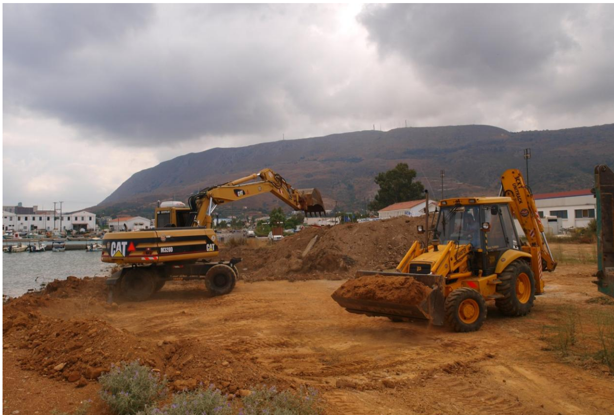
Φωτ. 23. Το ξεκίνημα των εργασιών για την απομάκρυνση των μάζων
